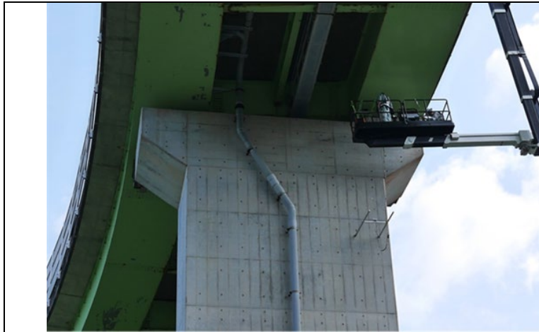
高解像度カメラによる橋脚の点検
