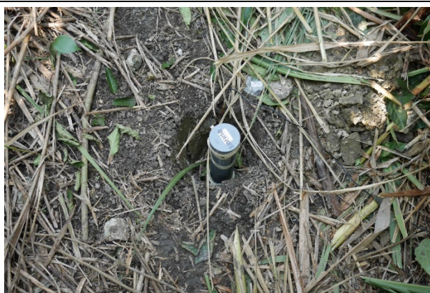
図 2.1.3-2 子機の設置状況
