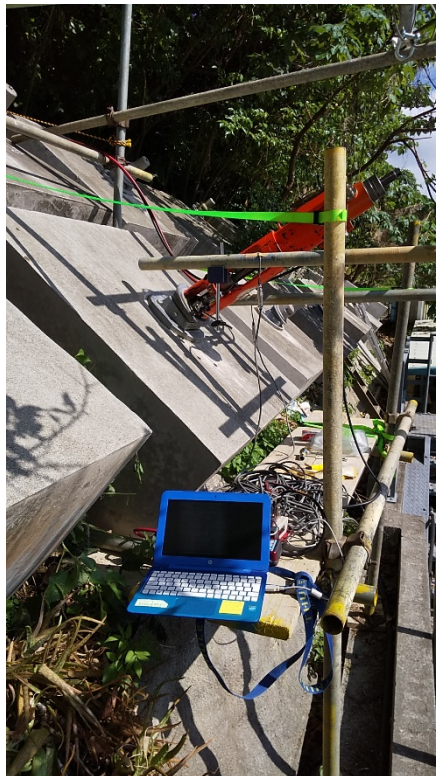
図 2.2.1-1 リフトオフ試験の実施状況
